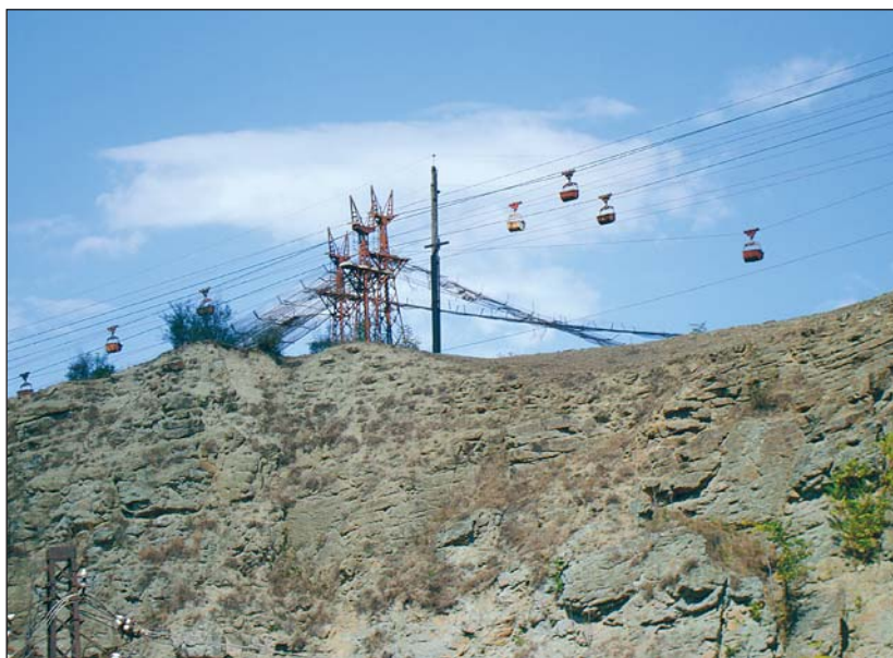
Рис.3. Канатные дороги от рудника.
